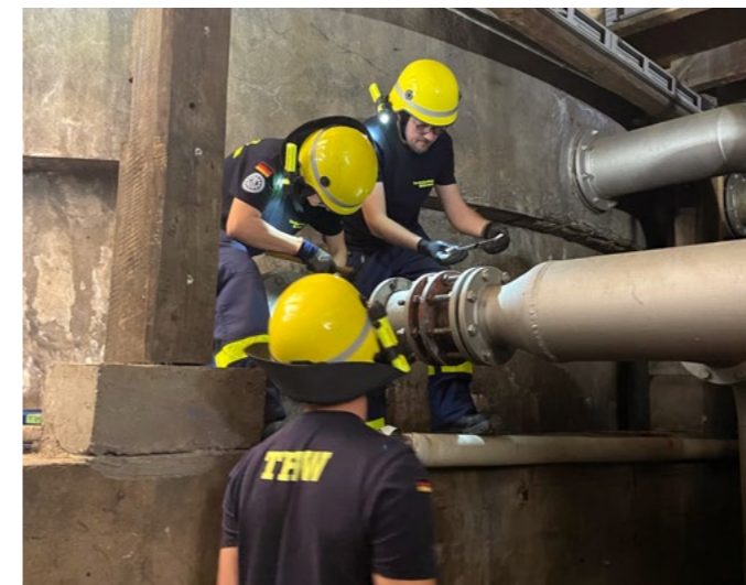
Bei einer Übung trainieren Einsatzkräfte die Instandsetzung beschädigter Leitungen.
