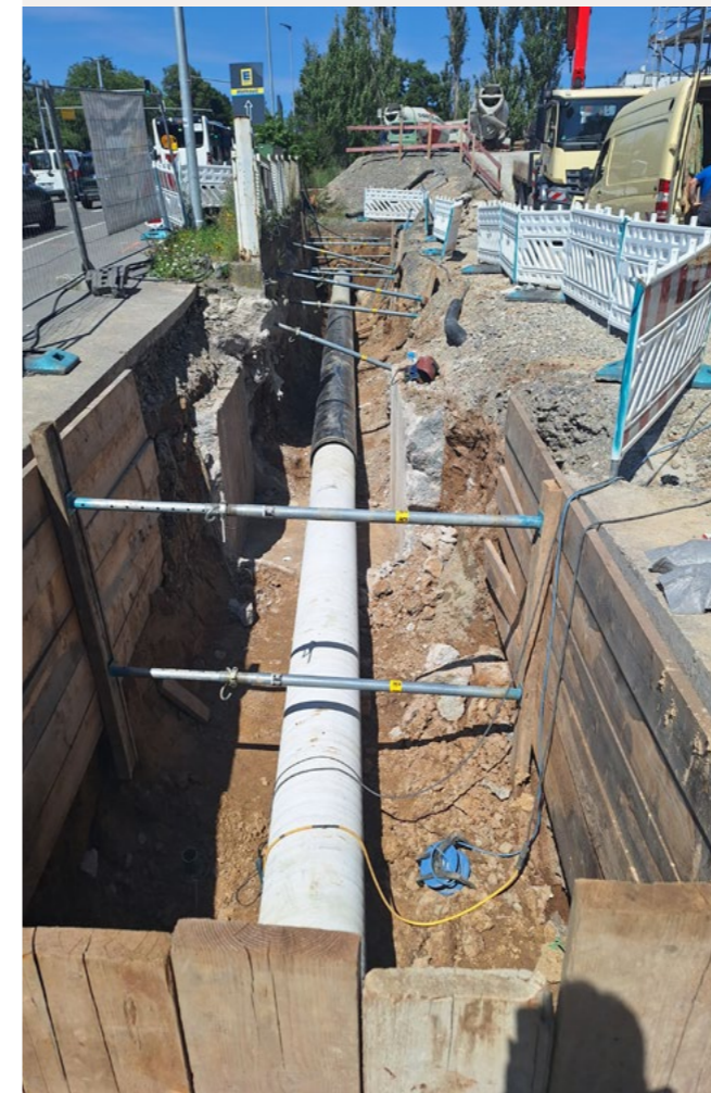
Das Medienrohr wird im Bereich der Überbauung durch ein Schutzrohr geschützt.
