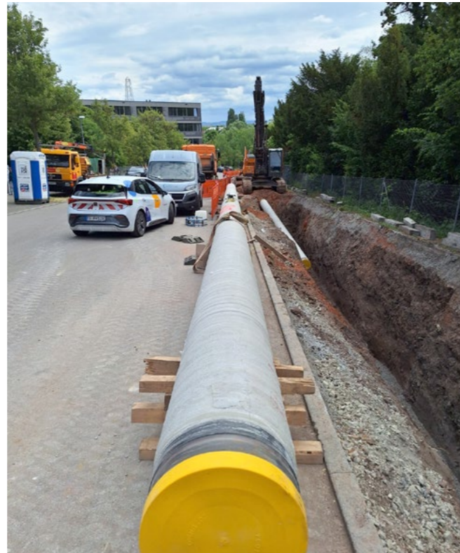
Baustelle der neuen Zubringerwasserleitung: Die Leitungsstraße entsteht Schritt für Schritt.
