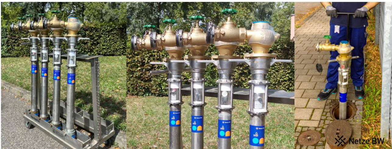
Abbildung 13: Bauwasser- und Hydrantenstandrohr der Netze BW Wasser GmbH
