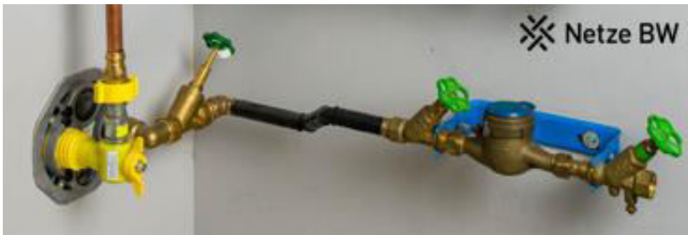
Abbildung 3: Die Mehrspartenhauseinführung
