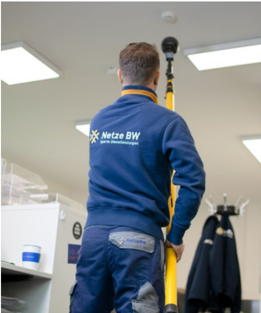
Funktionsprüfung von Rauchmeldern
